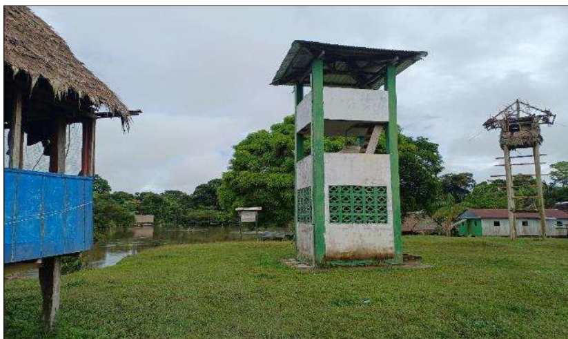
Fotografía N° 2. Estructura de concreto de la Planta de Agua en la zona a menos de 20 metros de la zona inundable y posible afectación a causa de la erosión.
